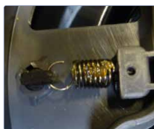
Blocage du câble à la longueur désirée
