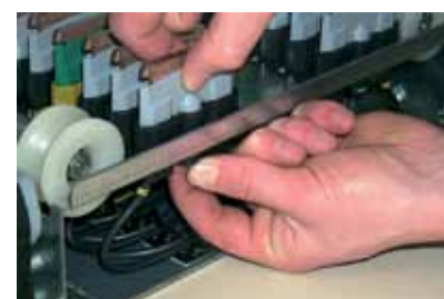
Remplacement des balais à blocs de charbon
