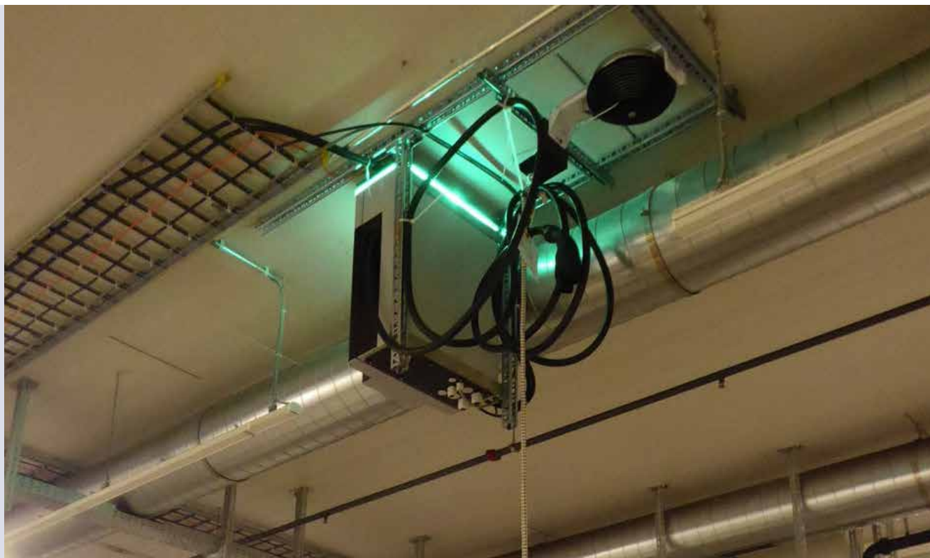
Gestion des câbles avec câble de recharge CCS / câble de recharge AC
