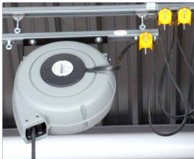
Enrouleur de câble en combinaison avec une installation de chariots de câbles dans un dépôt des pompiers
