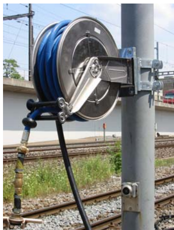
Schlauchaufroller VA mit spezieller Halterung
